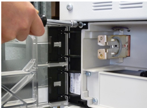
Fig. 21 / Figura 21: Fastening the plugged-on strip left / Fissaggio del sezionatore sul lato sinistro
