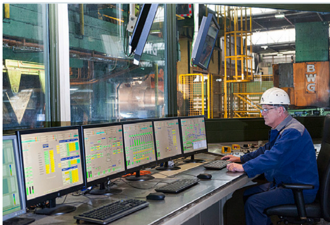
Référence : Poste de supervision V7
