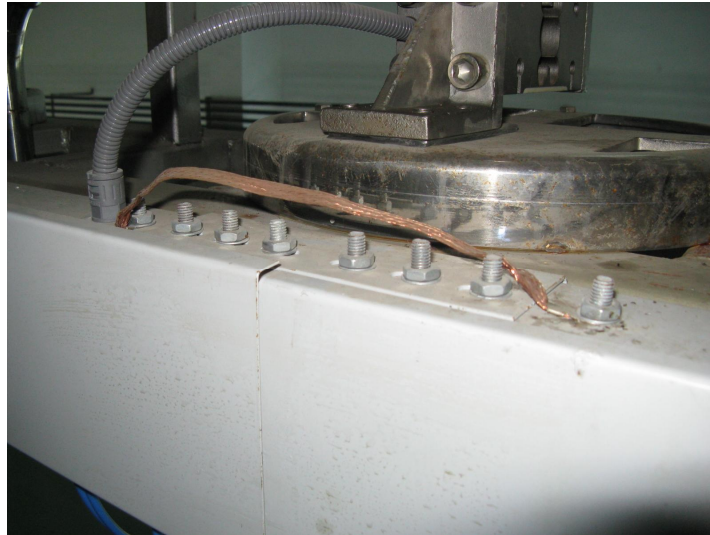
图26 电缆桥架之间的连接以及接地处理
