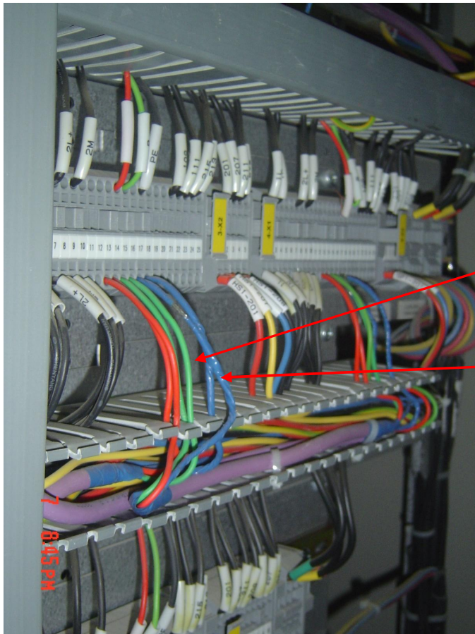
图39 屏蔽电缆的“猪尾巴”连接
