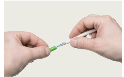
Außenmantel abnehmen und Geflechtschirm freilegen
