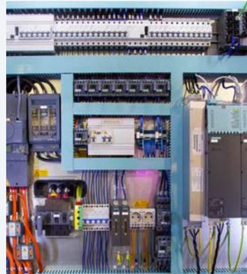
Geräteschutzschalter (GS) sind vorgesehen für den Schutz der Steuerstromkreise innerhalb elektrischer Betriebsmittel einschließlich ihrer Komponenten (z.B. Motoren, Sensoren, Anzeigen, interne Verdrahtung).
