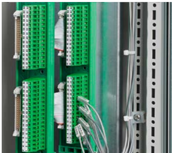
图 10-89 装机装柜型端子模块
