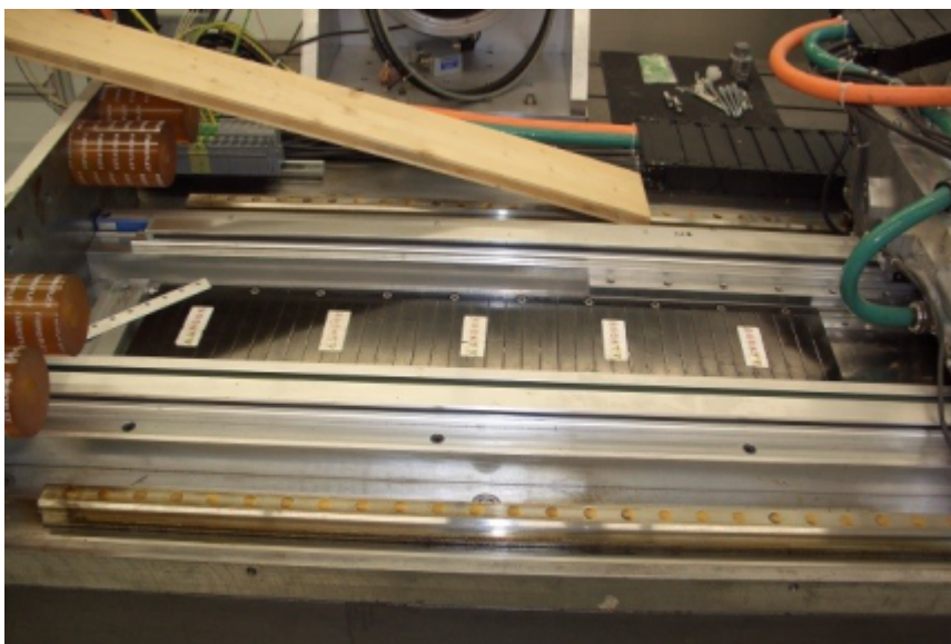
图 7-7 安装连续整段式盖板的初始情况
