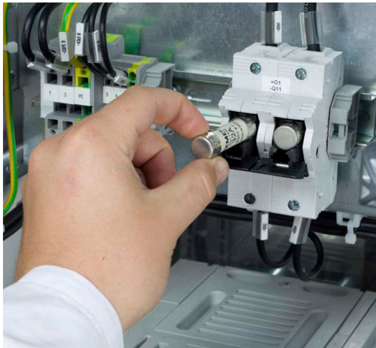
Bild 9-5 Tausch einer Rohrsicherung
