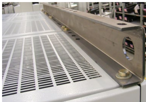
Bild 3-9 Option M90 mit Tragschienen
