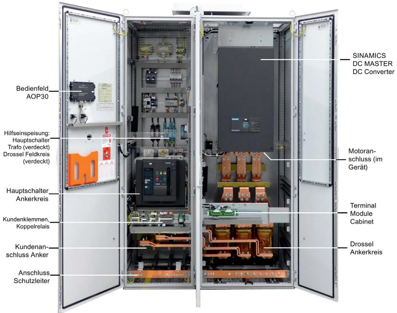
Bild 2-8 Übersicht Hauptkomponenten, Baugröße EC
