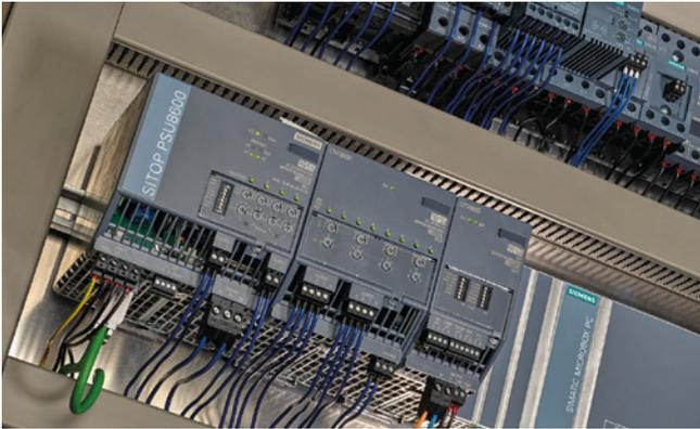
SITOP PSU8600 – ein neues Grundgerät 4 x 5 A ermöglicht die einzigartigen Funktionen des Stromversorgungssystems auch an 1-phasigen Netzen – siehe Seite 6/7.
